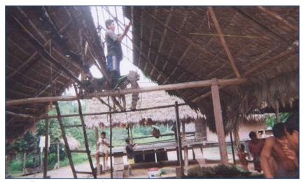
Fotografía № 12. Construcción del techo de una casa, utilizando las hojas de shapaja recolectadas del bosque en la comunidad Platanillo de Getarine (Pìchis).
