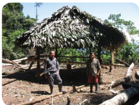
Campamento recién construido
