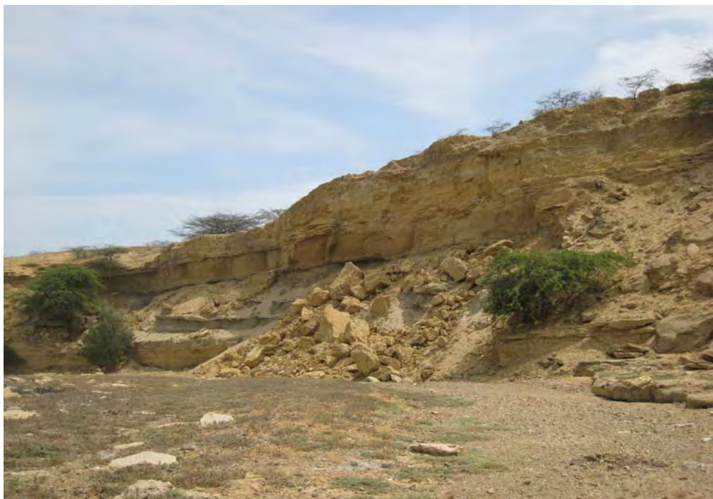
Fig. 6.9. Derrumbe rocoso de calizas de la formación Tablazo Talara, parte sudoccidental del macizo Amotape.
