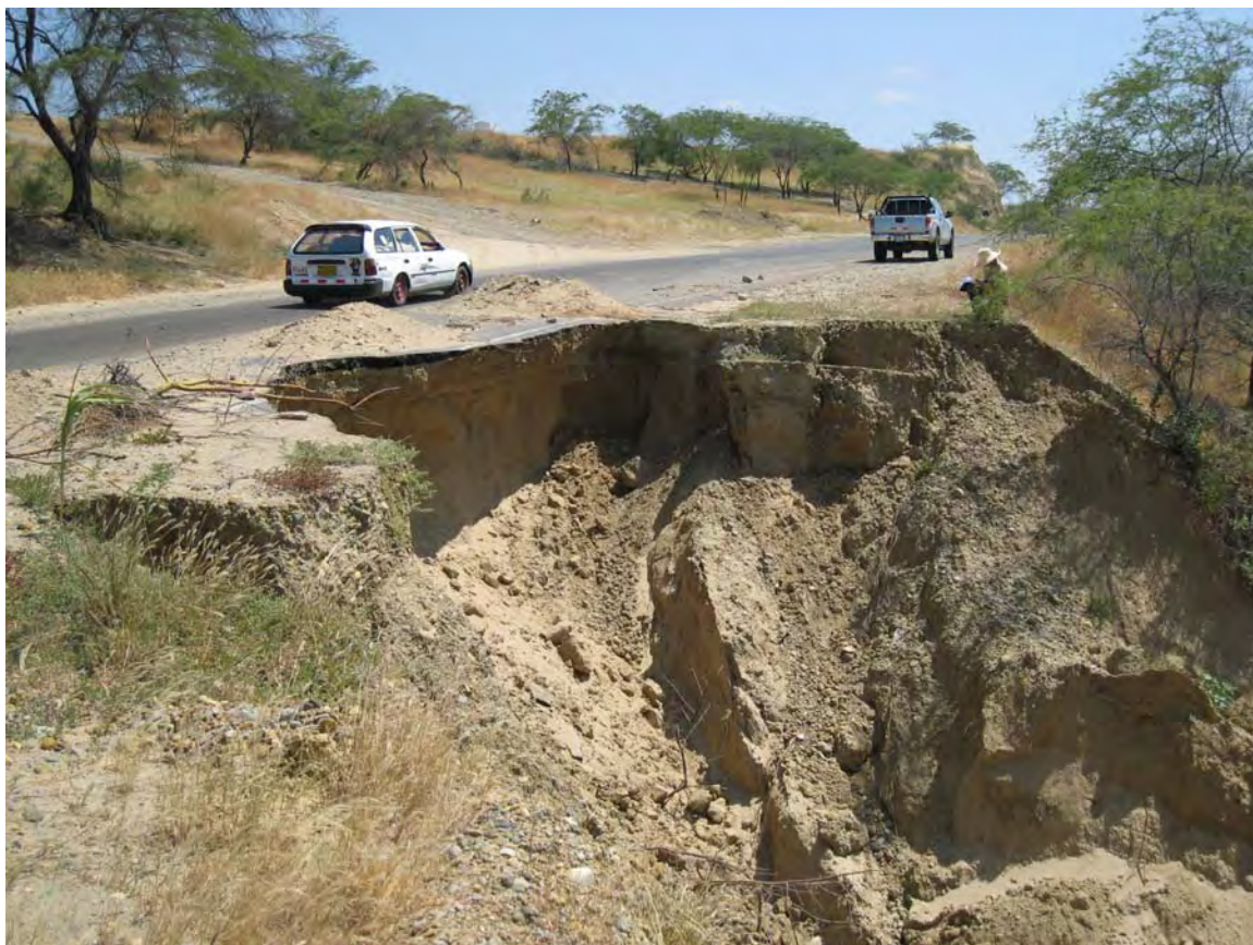
Fig. 6.14. Problemas de erosión de la carretera construida sobre los sedimentos eólicos no consolidados.
