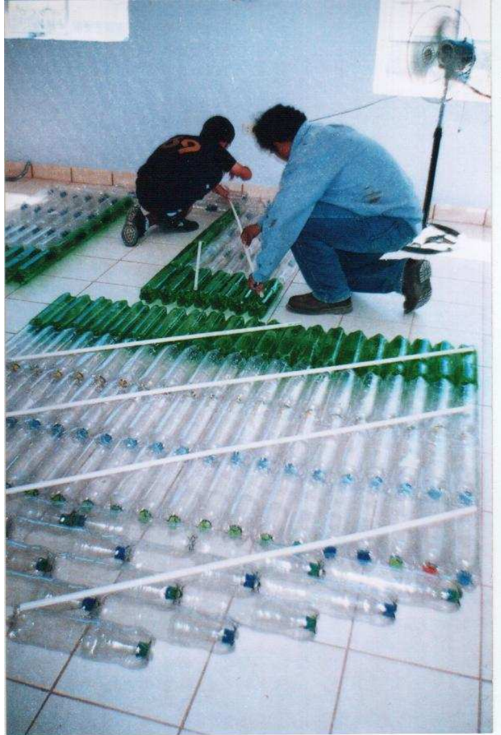
Reforzando las paredes con tubos de 5/8
