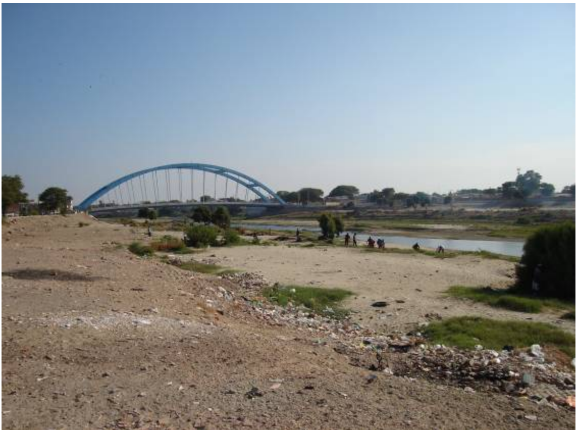
La Cámara de Bombeo Bolognesi ubicada en la ciudad de Castilla cerca del estribo izquierdo del Puente Bolognesi, provoca malos olores que son percibidos cuando se transita por éste.
