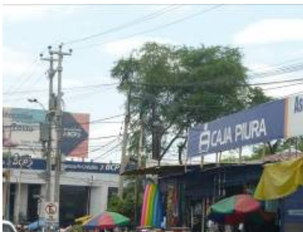
Líneas eléctricas de media tensión cruzan el perímetro del Mercado de Piura
