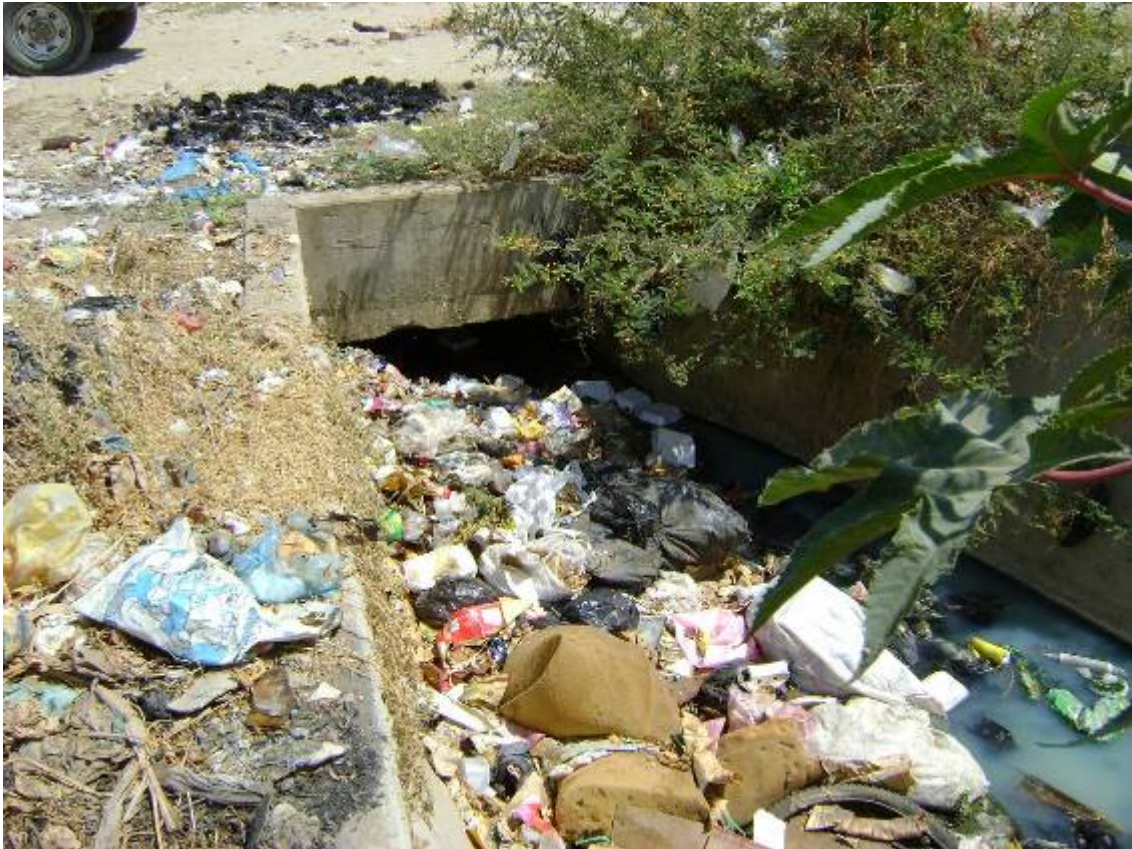
Dren César Vallejo colmatado con residuos sólidos y que también recibe aguas servidas no tratadas del Sector Los Polvorines en la ciudad de Piura.
