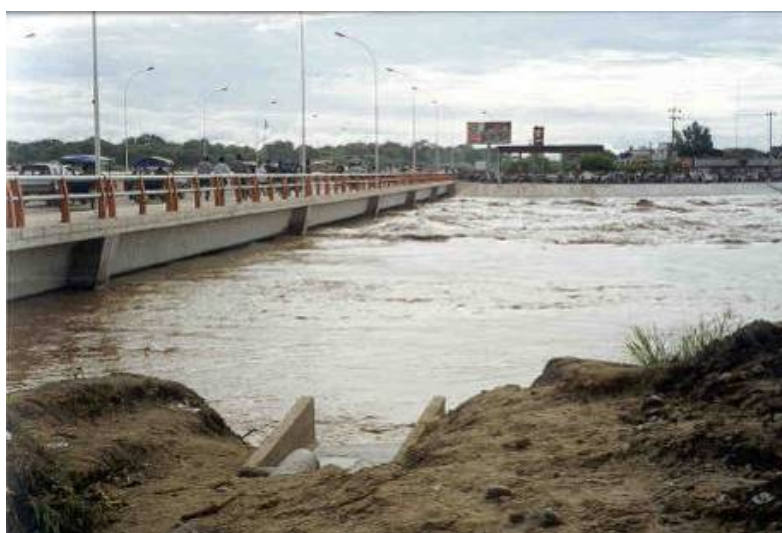
Vista del puente Cáceres con el caudal de 4400 m 3 /s
