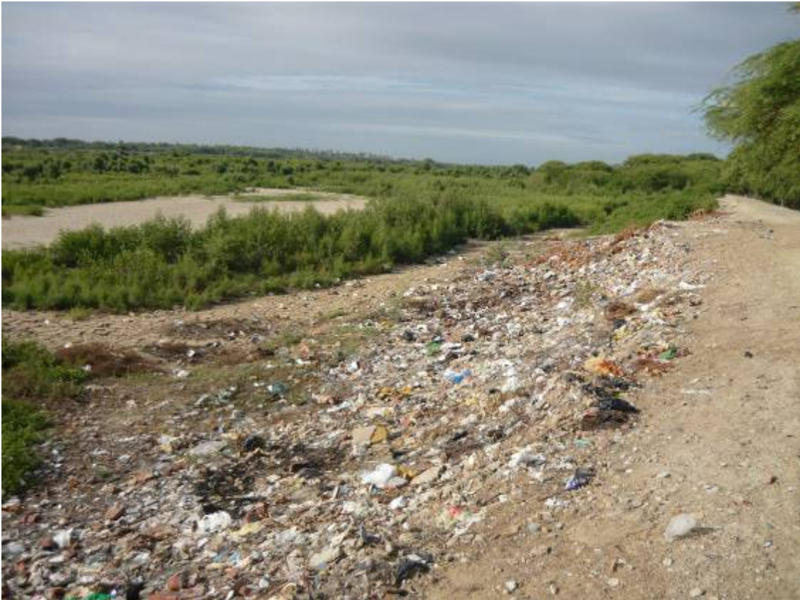
Dique de Tierra sobre la margen derecha del Río Piura aguas abajo del Puente Bolognesi y que actualmente constituye un Botadero de residuos sólidos.
