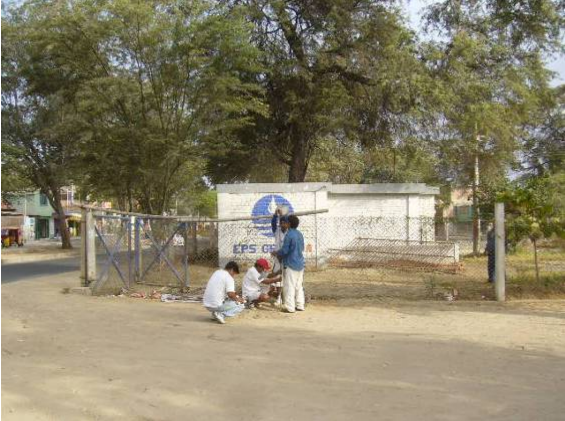
Las Cámaras de Bombeo de aguas servidas de la ciudad de Piura (Cámara San José en la foto) producen malos olores en los alrededores de la misma afectando a los pobladores.
