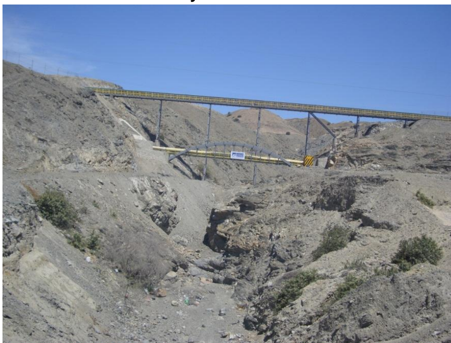
Fotografía 3.3.4-19. Paso de la faja transportadora de fosfatos y tubería del oleoducto por quebrada que trae huayco en época de ocurrencia de lluvias extraordinarias y el fenómeno de El Niño.
