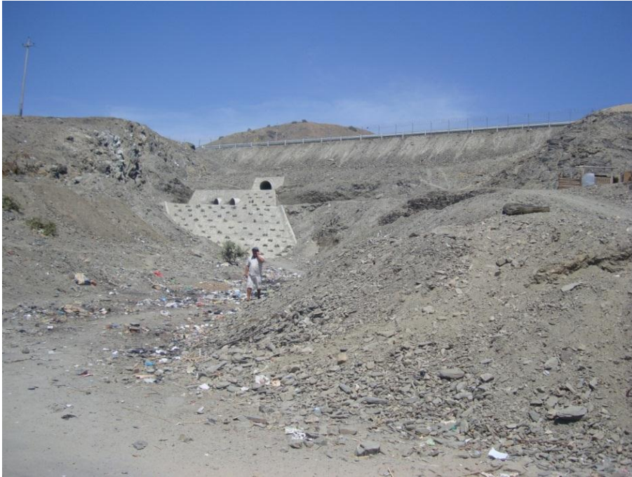
Fotografía 3.3.4-20. Vista al cauce de una quebrada ubicada a la altura de la caleta Puerto Rico donde se ha efectuado obra de envergadura para el paso de la faja transportadora de minera Bayóvar.
