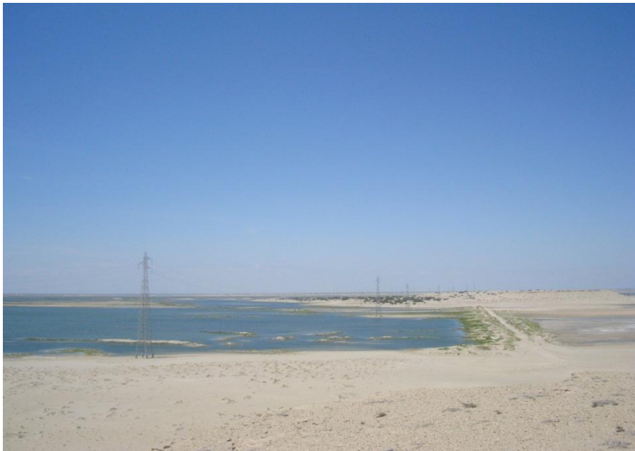
Fotografía 3.3.4-10. Nos muestra el pase de la línea de transmisión de 138 Kv subestación laguna La Niña – mina de Fosfatos Bayóvar
