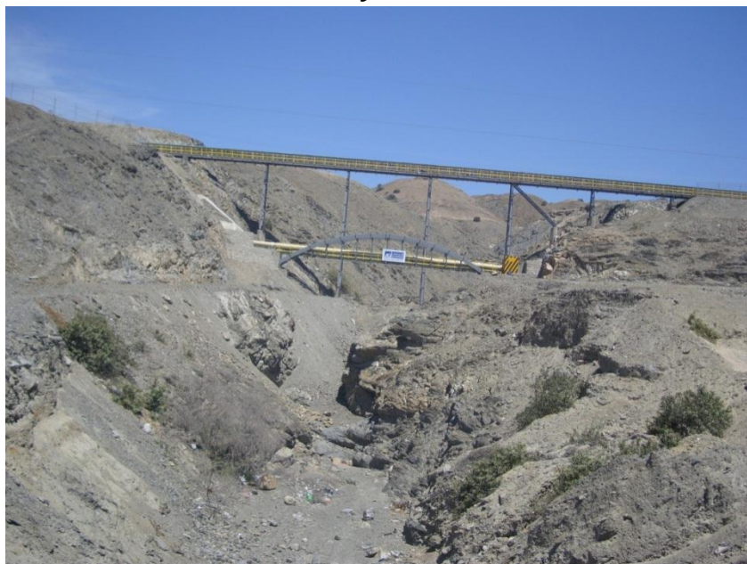
Fotografía 3.7.2-5. Paso de la Faja transportadora de fosfatos y tubería del oleoducto por una quebrada que trae huayco en época de ocurrencia de lluvias extraordinarias y el Fenómeno de El Niño
