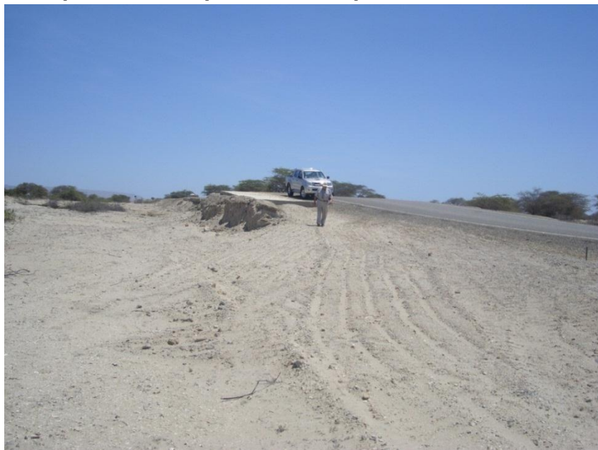
Fotografía 3.7.2-3. Vista a carretera Bappo – Desvió Chiclayo, erosionada por torrente que discurrió por lecho de quebrada en el Niño del 1997-98.
