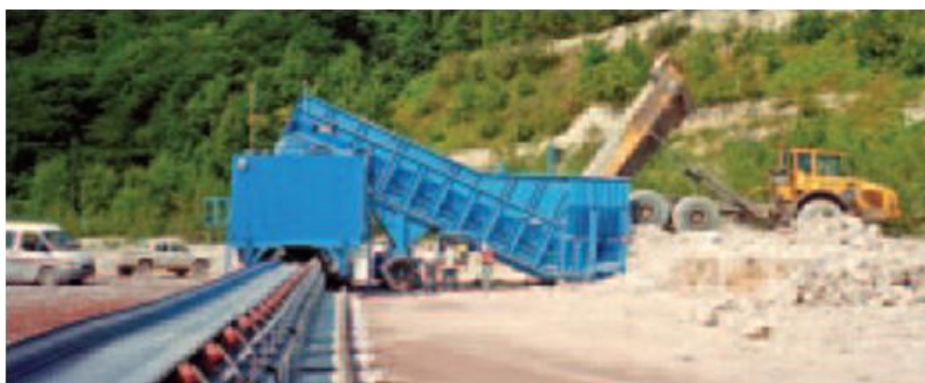
Figura 4.4.3.2-9. Descarga de camiones en la tolva y traslado de mineral con fajas hacia la planta beneficio.
