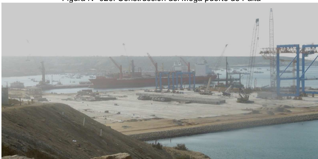
Figura N° 020: Construcción del Mega puerto de Paita
