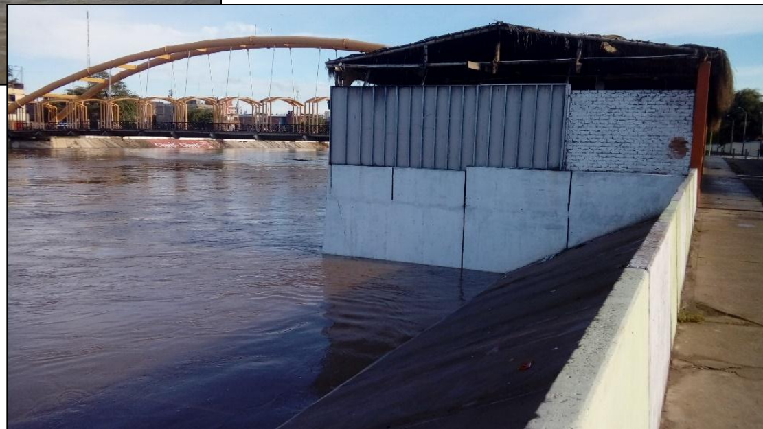
Río Piura – margen izquierda: Parte posterior del restaurant ocupando el cauce.
