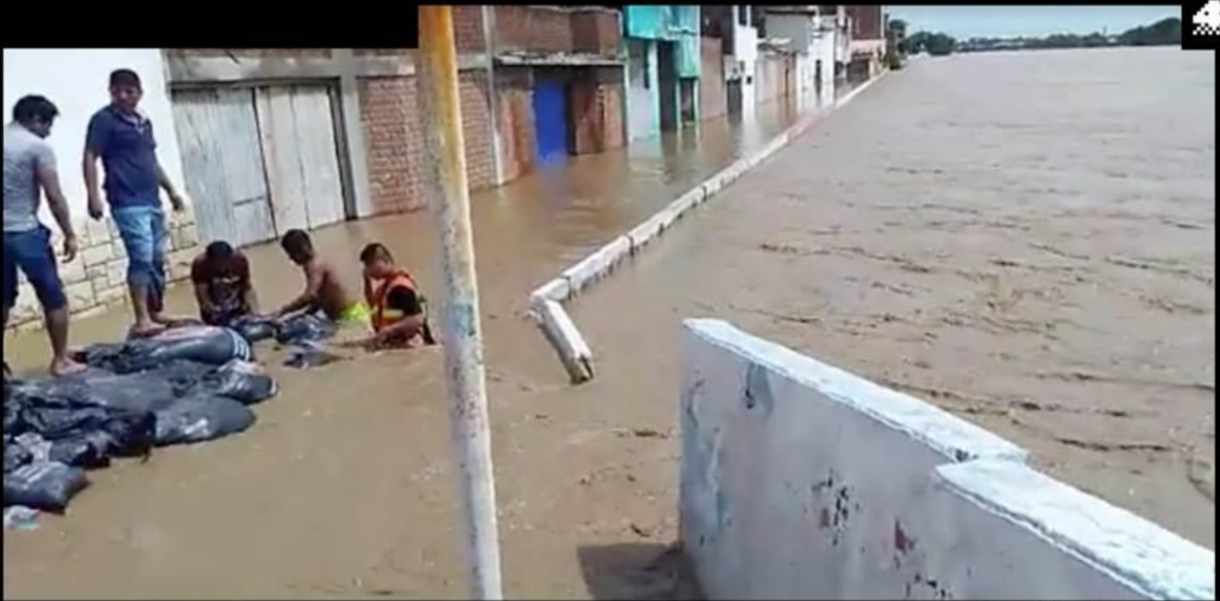
Desborde del río Piura en la ciudad.
