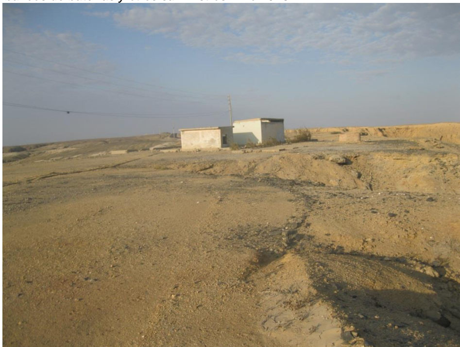
Figura 8. La foto muestra la casa del personal de mantenimiento y la caseta donde se ubicaron los bancos de baterías y otros suministros. Año 2016.
