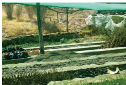
Planta de tratamiento de Carhuasyilka de la Municipalidad Provincial de Huaraz (5)
