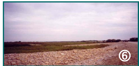
Espigones cuya ubicación y dimensiones deben obedecer a la respuesta de un Modelo Hidráulico –(Fotos 5 y 6)
