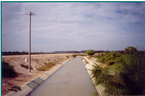
Canal Sinchao, ubicado en la Margen Derecha
