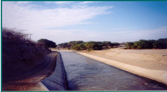
Tramo ubicado en la M. Derecha del R. Piura
