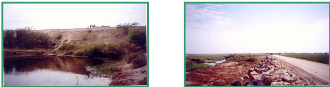
Dren 13.08 ingresando al Sifón Dique de encauzamiento del río que cruza el río Piura de la Margen Izquierda a la M.D -Piura – Mayo 2004
