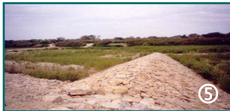
Espigones cuya ubicación y dimensiones deben obedecer a la respuesta de un Modelo Hidráulico –(Fotos 5 y 6)
