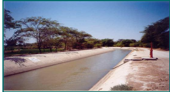
Tramo Inicial – Margen Izquierda R. Piura
