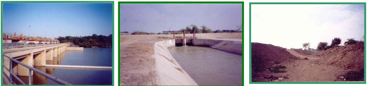
Presa de Derivación Los Ejidos Canal Principal Biaggio Arbulú Dren 13.08 Mayo 2004
