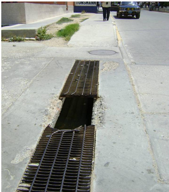
**FOTO Nº 23:** Rejilla de captación del Dren Gullman, colmatadas con basura y totalmente deterioradas en la zona del Coliseo Gerónimo Seminario y Jaime
