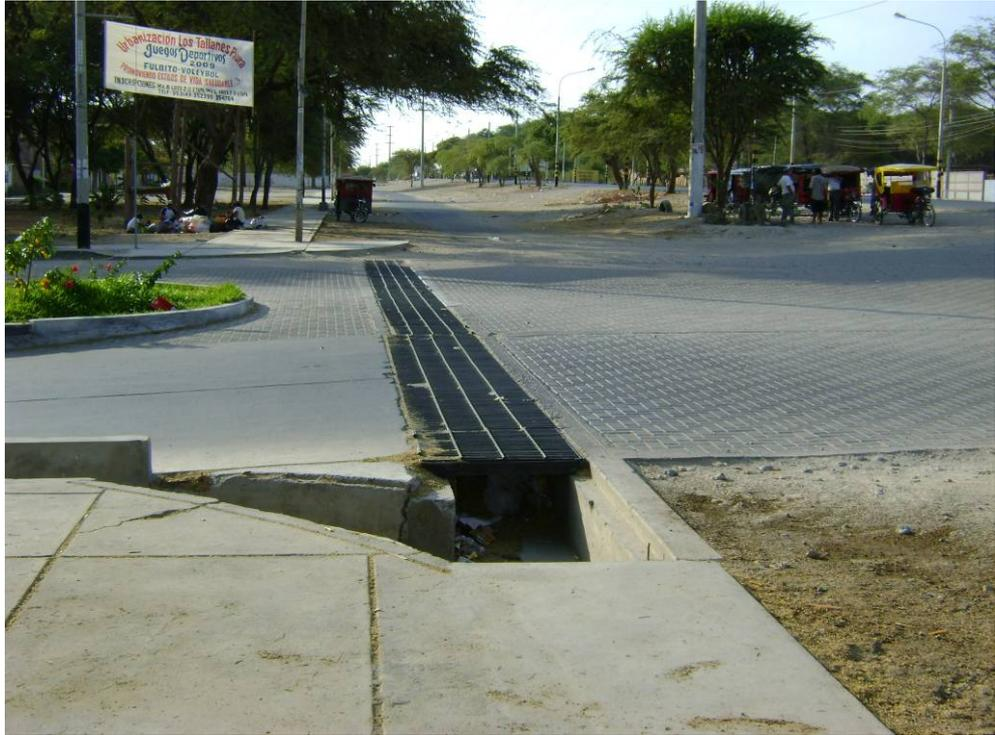
**FOTO N° 39:** Rejilla de captación en la intersección de la Av. Los Tallanes y la Av. Marcavelica totalmente colmatado con basura. Ciudad de Piura.
