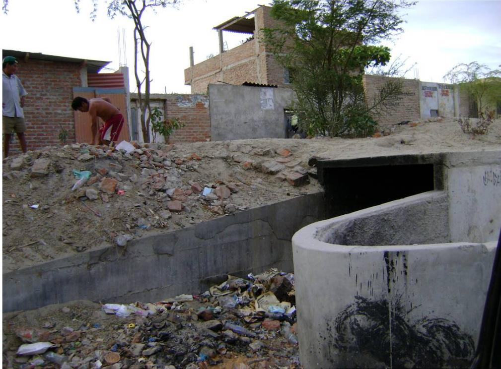
**FOTO N° 43:** Salida de Dren Marcavelica subterráneo, totalmente colmatado con basura. Ciudad de Piura.
