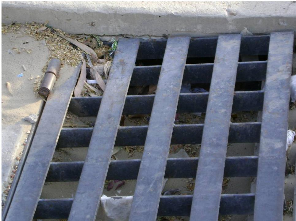
**FOTO N° 42:** Rejilla de captación en la intersección de la Av. Marcavelica y la Av. Circunvalación, totalmente colmatado con basura. Ciudad de Piura.
