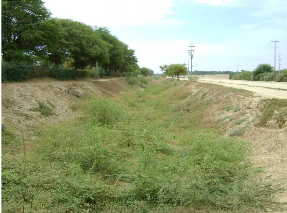
**FOTO N° 51:** Inicio del Dren 1308, totalmente colmatado con sedimentos. Ciudad de Castilla.
