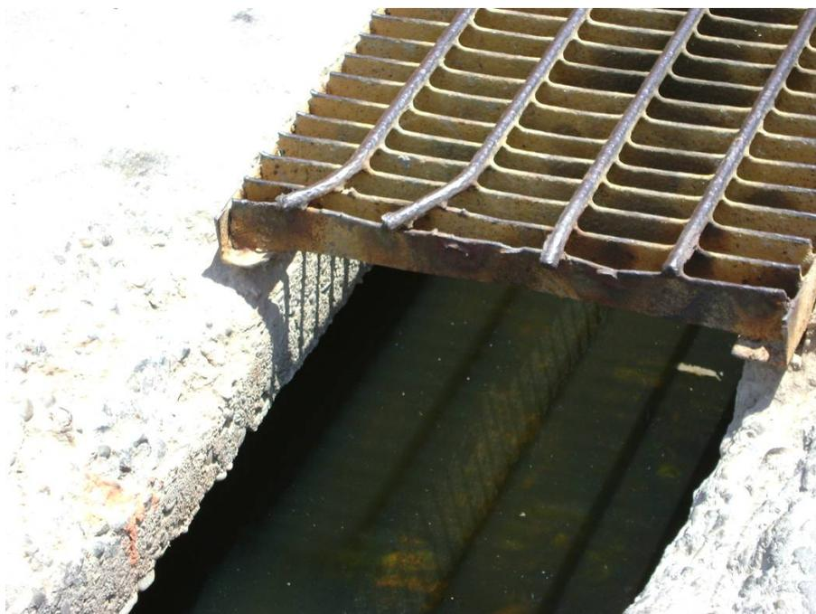
**FOTO Nº 24:** Rejilla de captación del Dren Gullman, colmatadas con basura y totalmente deterioradas en la zona del Coliseo Gerónimo Seminario y Jaime
