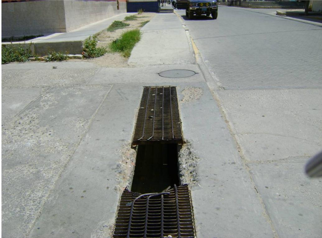
**FOTO N° 25:** Rejilla de captación del Dren Gullman, colmatadas con basura y totalmente deterioradas en la zona del Coliseo Gerónimo Seminario y Jaime
