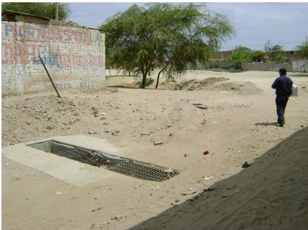
**FOTO N° 53:** Tubería de ingreso al Dren Primavera – Dren 1308, totalmente colmatado con sedimentos. Ciudad de Castilla.
