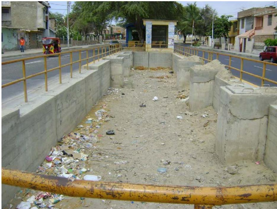
**FOTO N° 16:** Captación en la intersección de la Av. Grau con la Calle 11, con abundante basura dentro de su sección. Ciudad de Piura.
