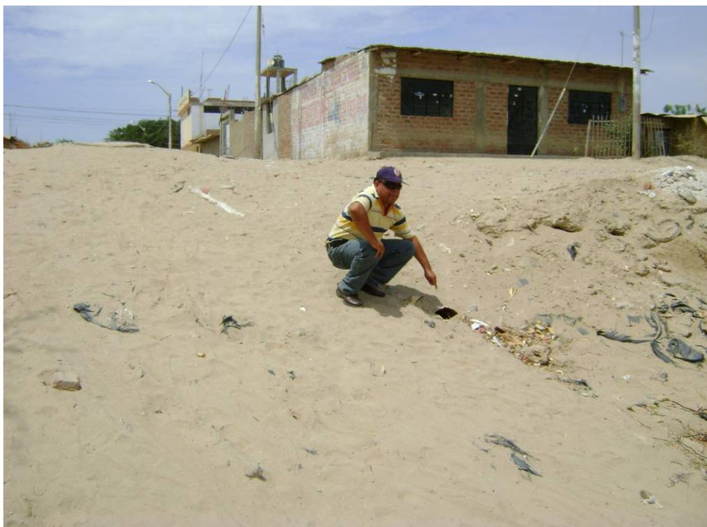
**FOTO N° 54:** Tubería de ingreso al Dren Primavera – Dren 1308, totalmente colmatado con sedimentos. Ciudad de Castilla.
