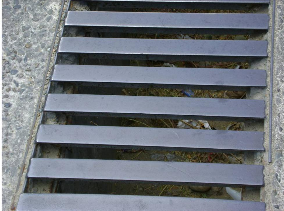
**FOTO N° 17:** Rejilla de captación en la intersección de la Av. Grau con la Calle 11, con abundante basura dentro de su sección. Ciudad de Piura.
