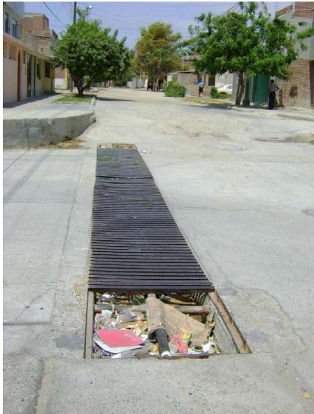
**FOTO N° 18:** Rejilla de captación en la intersección de la Av. Grau con la Calle 11, con abundante basura dentro de su sección. Ciudad de Piura.
