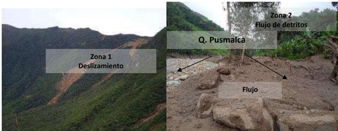
Figura 69. Vista en perspectiva de las zonas 1 y 2 del movimiento complejo (deslizamiento-flujo de detritos) en la quebrada Pusmalca.
