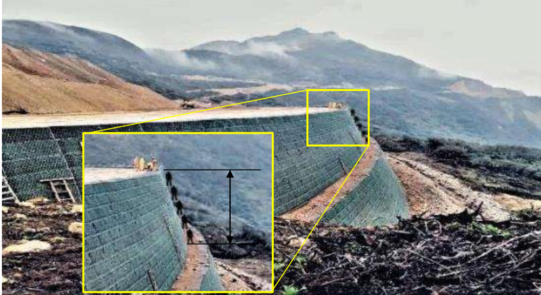
Figura 63. Vista lateral del DME-111. Fuente: Municipalidad Distrital de Canchaque, 2021.
