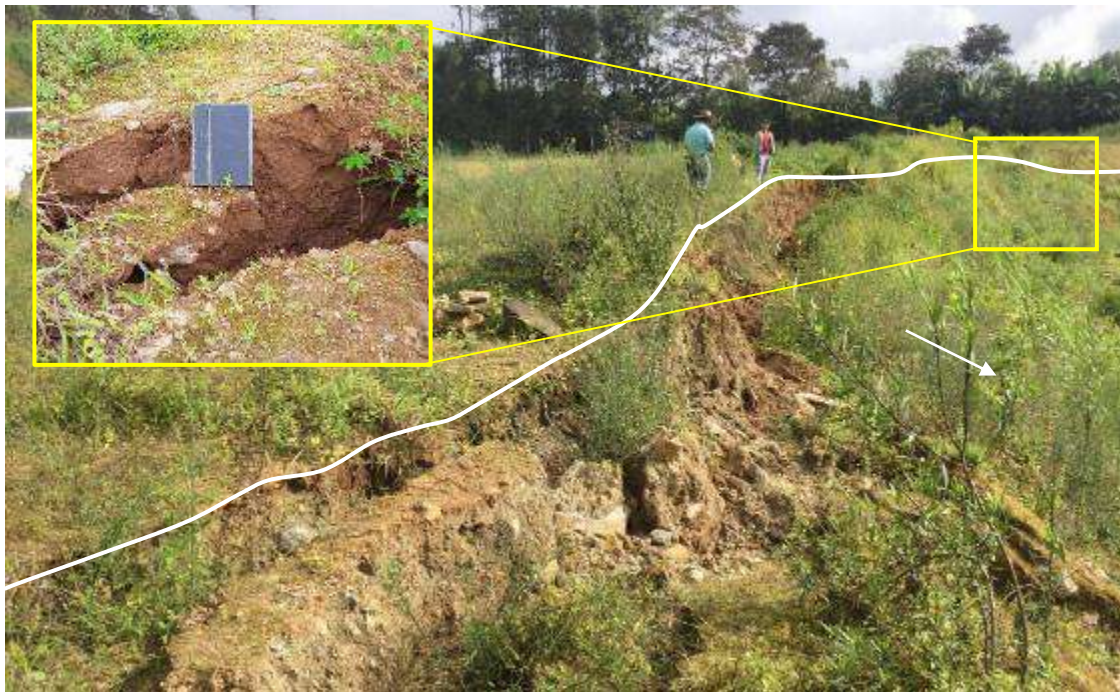
Figura 55. Vista del escarpe principal del deslizamiento en el DME-04.
