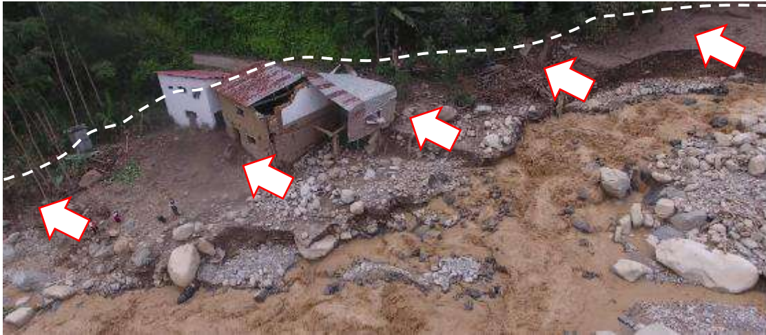
Figura 49. Vivienda totalmente destruida ubicada en el sector Potreritos.
