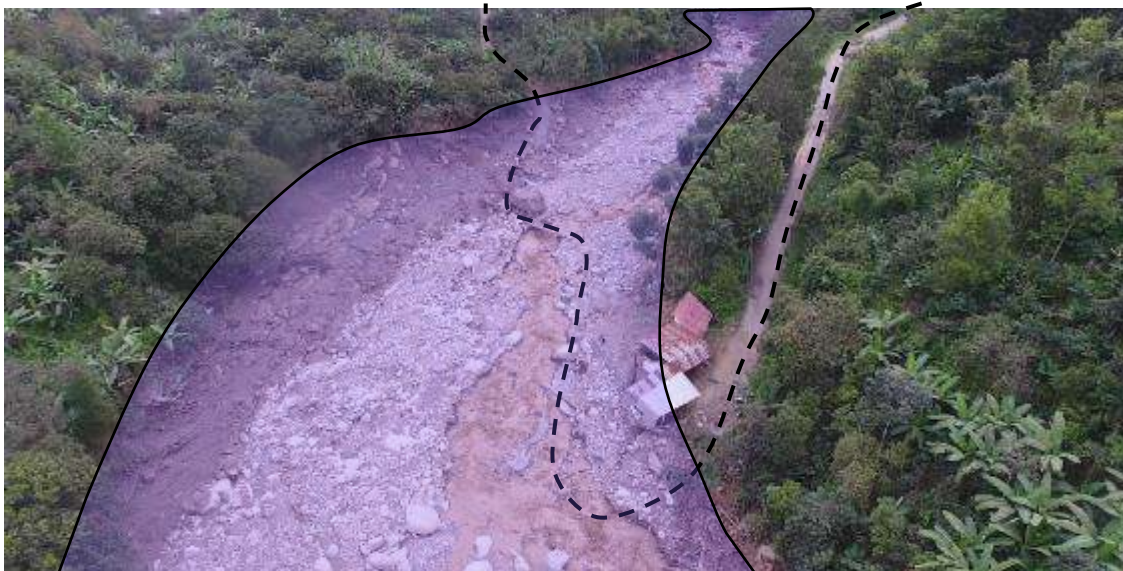
Figura 52. Tramo de la carretera Canchaque – Pusmalca – Maraypampa (km 0.23) destruida por el paso del flujo.
