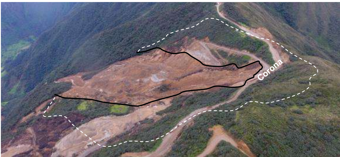
Figura 17. Vista de sur a norte de la corona parte superior del escarpe del material deslizado.
