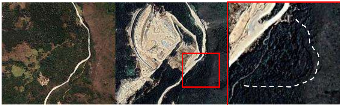
Figura 42. Formación de escarpe de forma cóncava en el talud superior de la vía Canchaque - Huancabamba.
