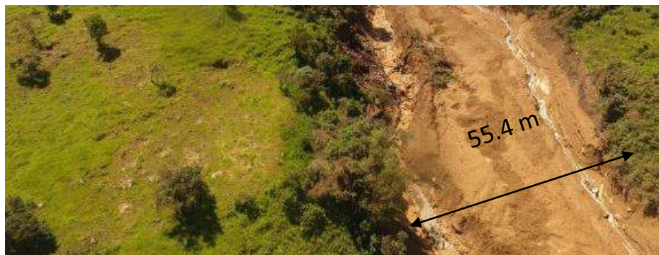
Figura 28. Vista del cauce de la quebrada Pusmalca y el ancho del flujo.
