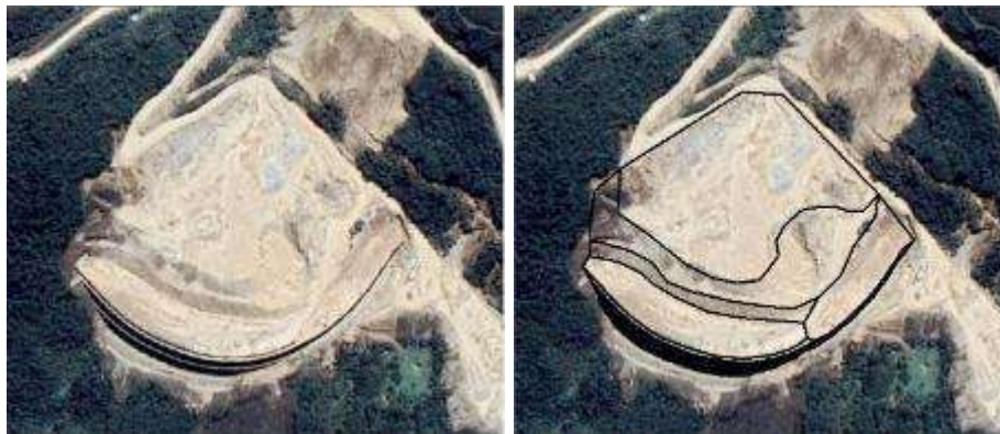
Figura 61. Imagen satelital de 01 enero 2021 donde se observa el DME-111.
