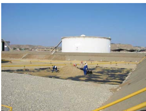
Figura 3.11.: Construcción de filtro natural.
