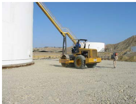
Figura 3.10.: Compactación de filtro natural.
