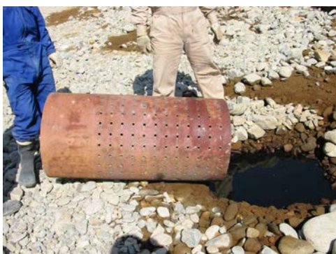
Figura 3.13.: Construcción de pozas de recuperación.
