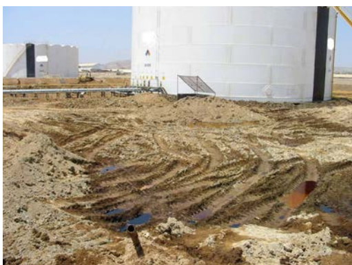
Figura 3.5.: Excavación del suelo contaminado.
