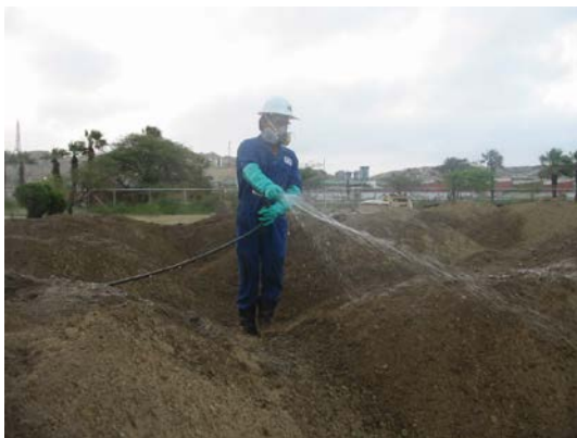
Figura 3.24.: Actividad de aplicación del caldo bacteriano.
