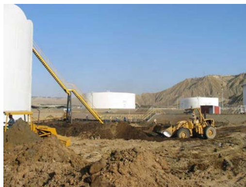
Figura 3.6.: Excavación de suelo contaminado.
