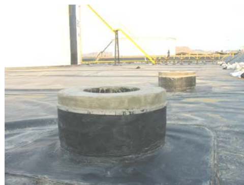
Figura 3.14.: Pozas de recuperación terminadas.
