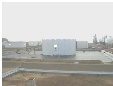
Figura 3.12.: Vista aérea del tanque terminado.
