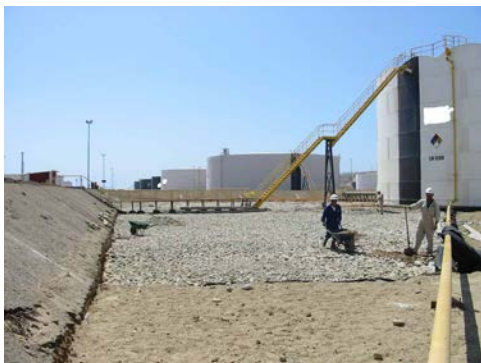
Figura 3.9.: Construcción de filtro natural.
