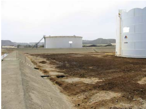
Figura 3.1.: Estado de referencia del lugar.
