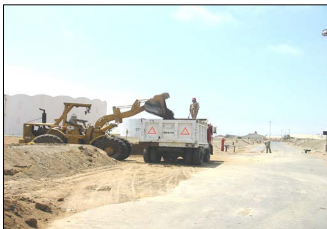
Figura 3.7.: Carguío de suelo contaminado.
