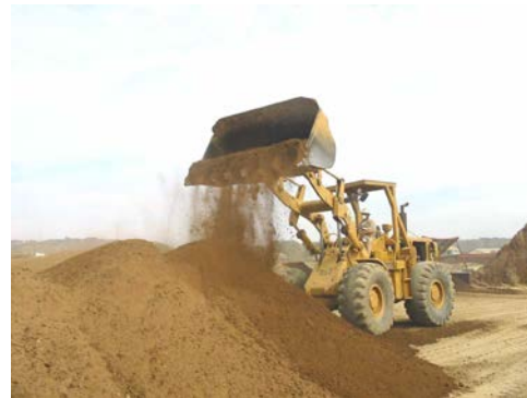
Figura 3.23.: Actividad de volteo mecánico.
