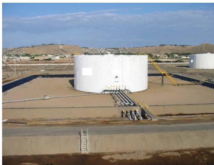
Figura 3.29.: Vista área del área estanca terminada.
