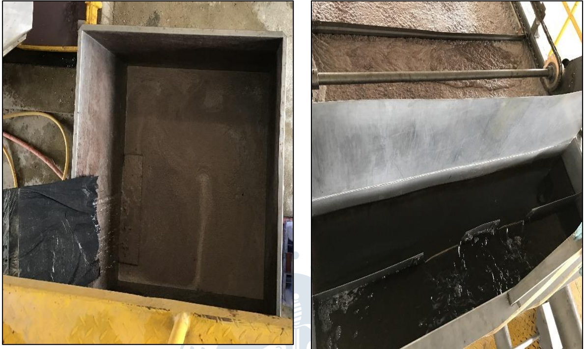
Tanque de lodos, obtenidos en el proceso - punto final del sistema.
