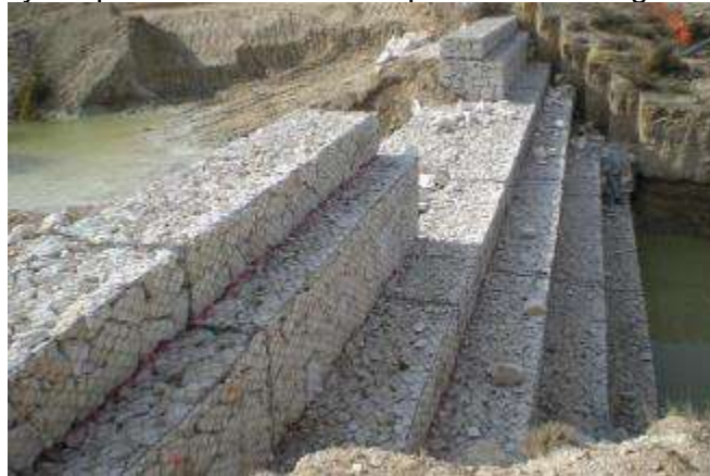
Figura 52. Dique de gaviones.
