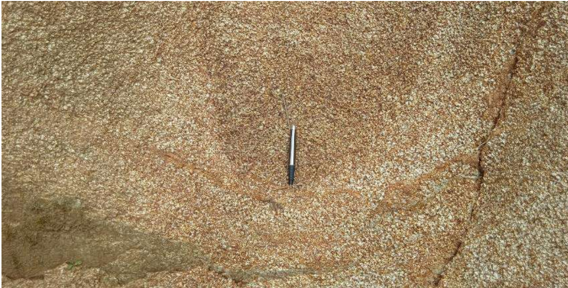
Figura 33. Granito se aspecto rosáceo muy deleznable en las coordenadas 9447578N y 647274E.
