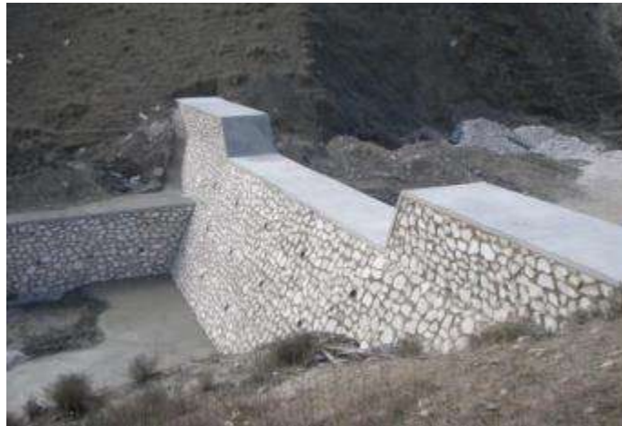
Figura 51. Dique de mampostería.
