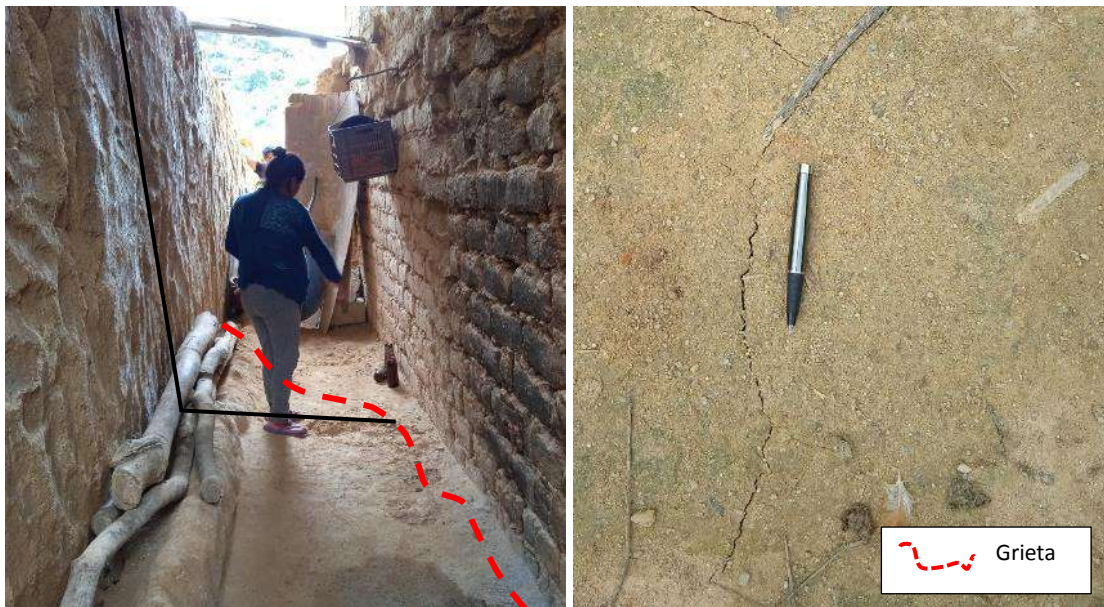
Figura 17. Grietas observadas en el interior de las viviendas, coordenadas 9447643N y 647400E.
