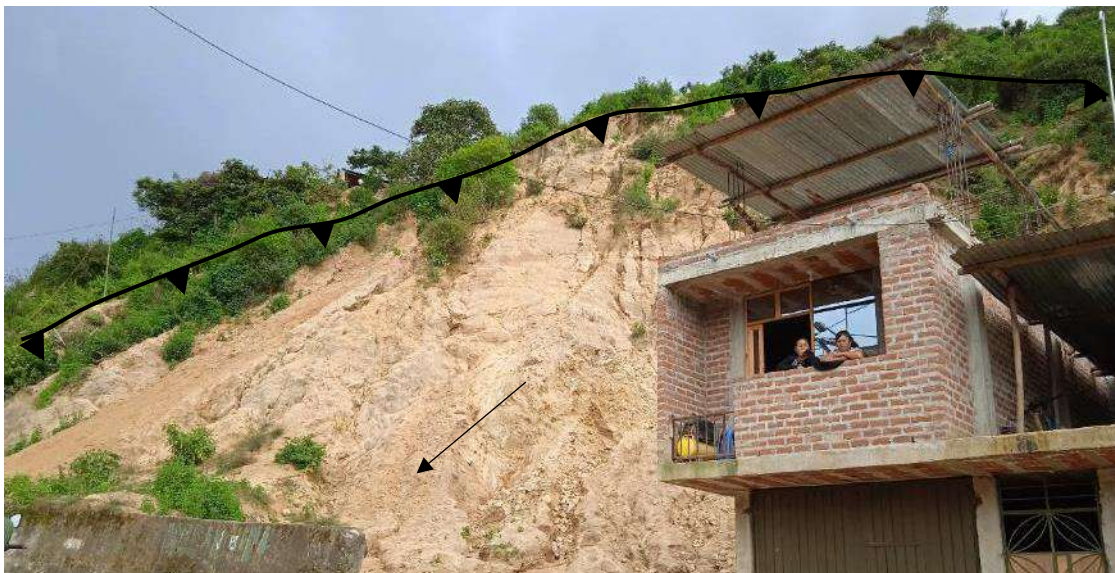
Figura 19. Vista frontal desde la calle La Unión donde 5 viviendas fueron afectadas por el deslizamiento.
