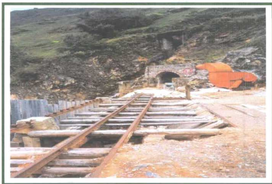
Foto 3.5. Vista de socavón inferior de mina San Nicolás.
