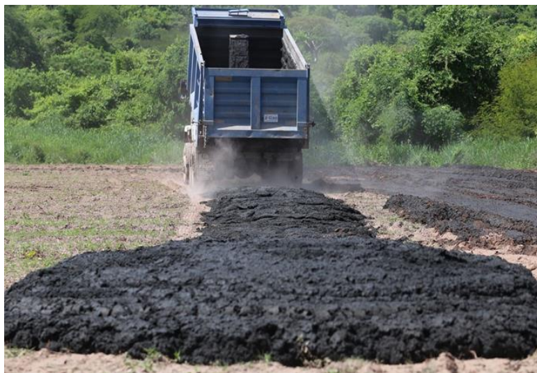
Figura 5. Aplicación de biosólidos.
