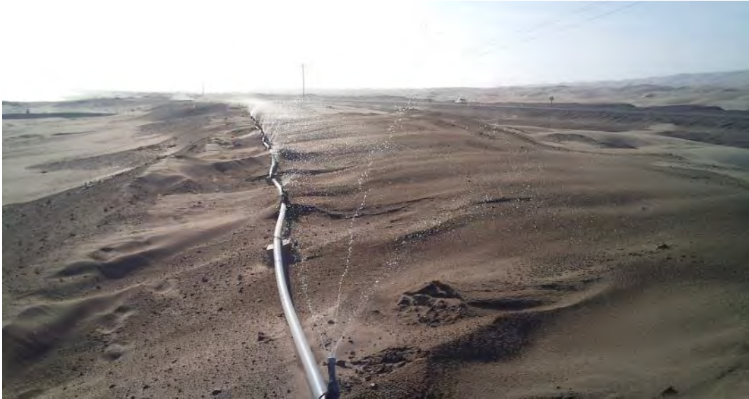
Foto 2.23 Inicio de pruebas de riego por aspersión en dique de prueba
