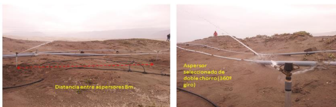
Fotos 3.10 – Distanciamiento de aspersores y pruebas para direccionar riego
