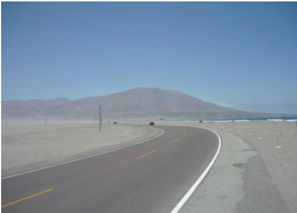
Foto 2.4 - Recorrido de canalización, adyacente a trazo de carretera.
