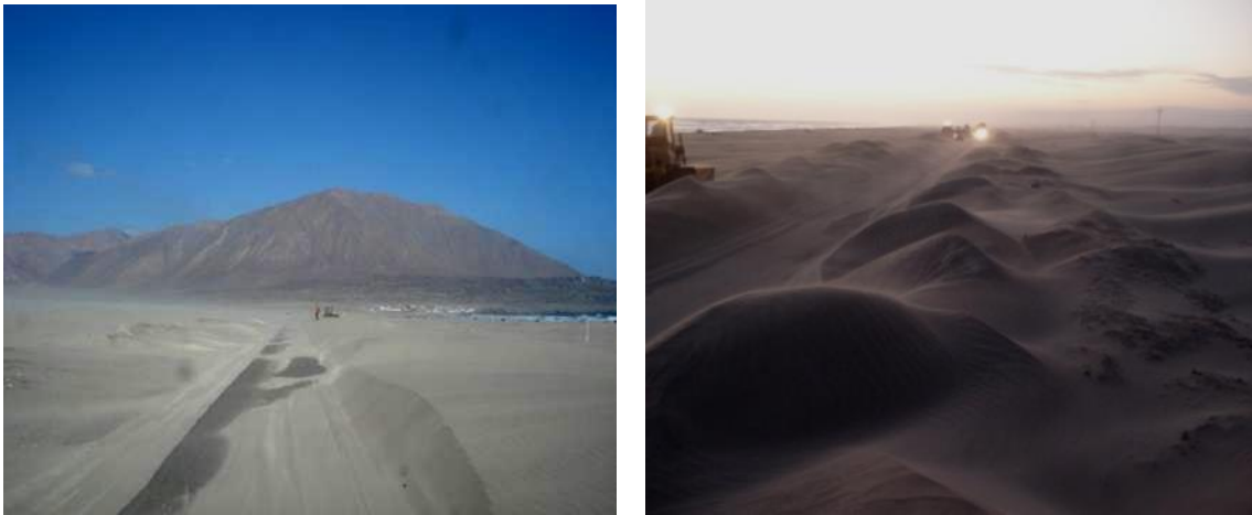
Foto 3.13 – Estado de la carretera en Tanaka, antes de junio del 2010
