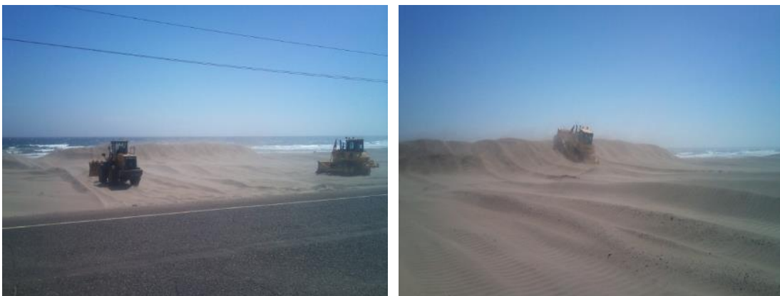
Foto 3.6 - Construcción del diques a 100 m. de la vía. Altura del dique 5 m.
