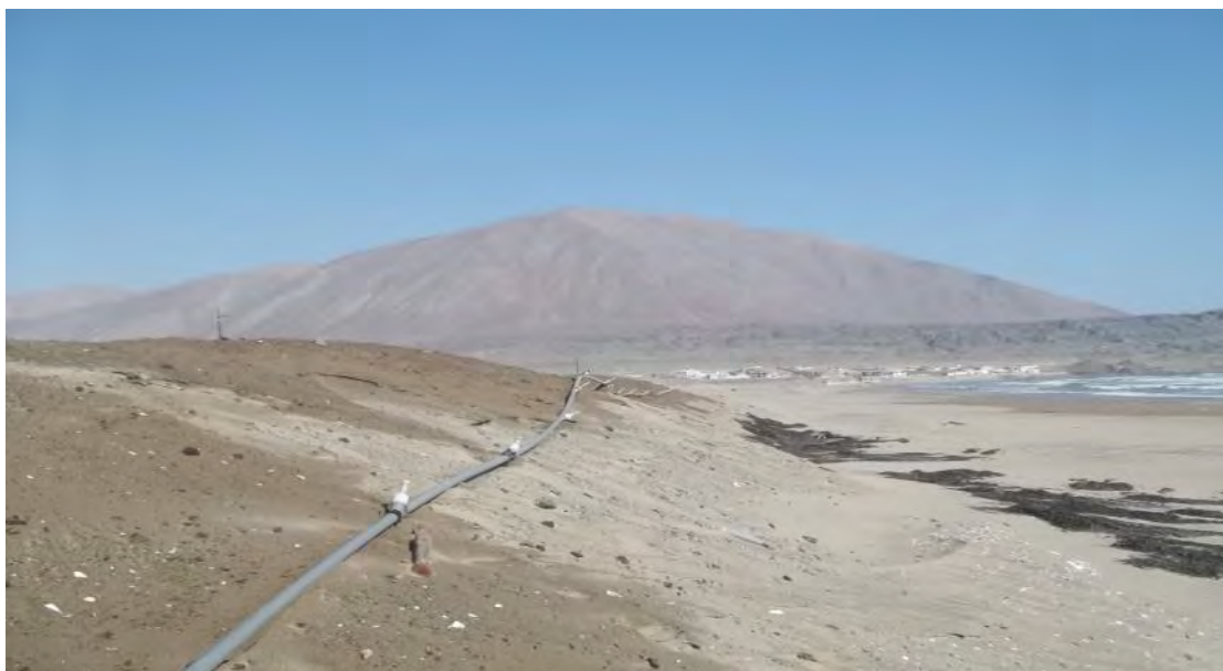
Foto 2.26 - Posición final de las tuberías de conducción. Longitud de prueba estimada en 110 m.
