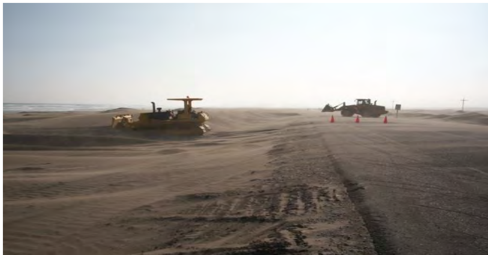
Foto 2.2 – Trabajos de desarenado con tractor orugas y cargador frontal (Julio 2010).
