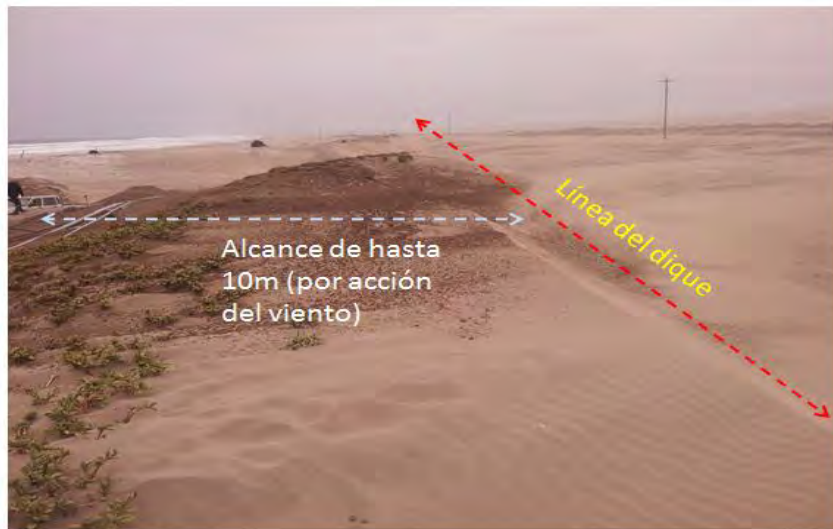
Foto 2.9 – Barrera o dique de arena para impedir arrastre del viento
