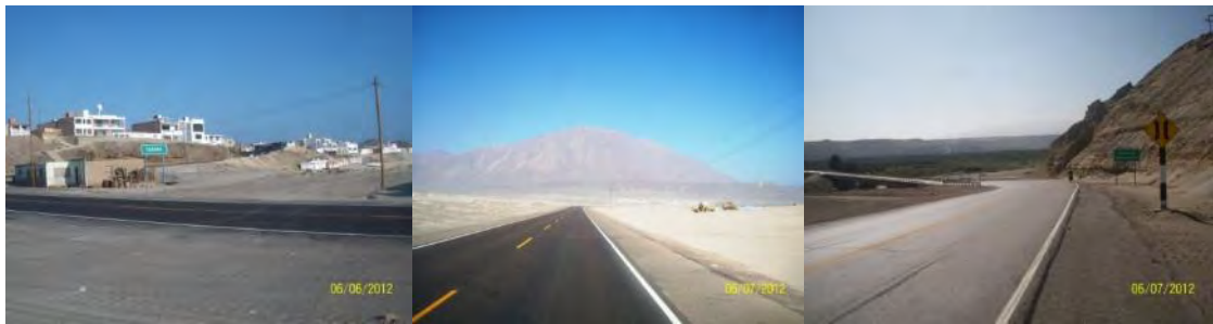
Fotos 2.33 – Estado de la carretera, después de la intervención.
