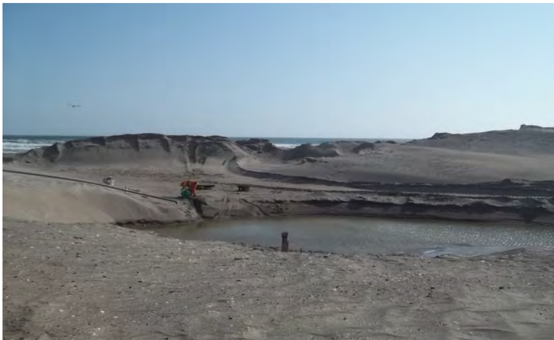
Foto 2.25- Pozo para la extracción de agua salada altura de 1.10 m en la parte más profunda
