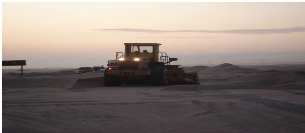
Foto 2.1 – Trabajos de desarenado con tractor neumático, marzo del 2010.
