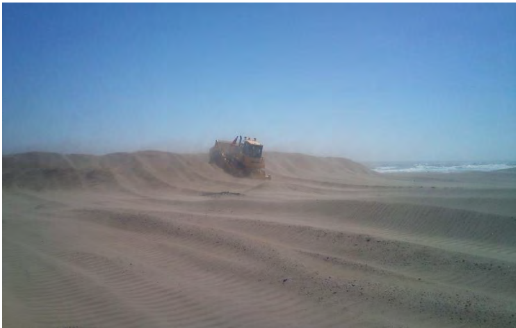
Foto 2.20 - Preparación del dique. Longitud alcanzada 210 m.
