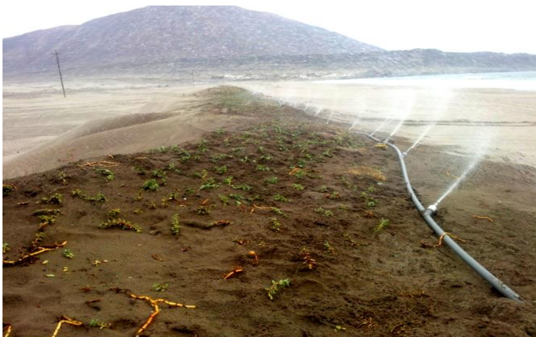
Foto 3.11 – Pantallas de agua por riego por aspersión
