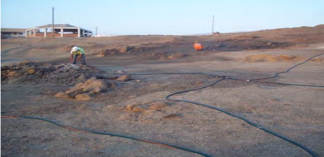
Foto 2.21. Pruebas iniciales con los aspersores
