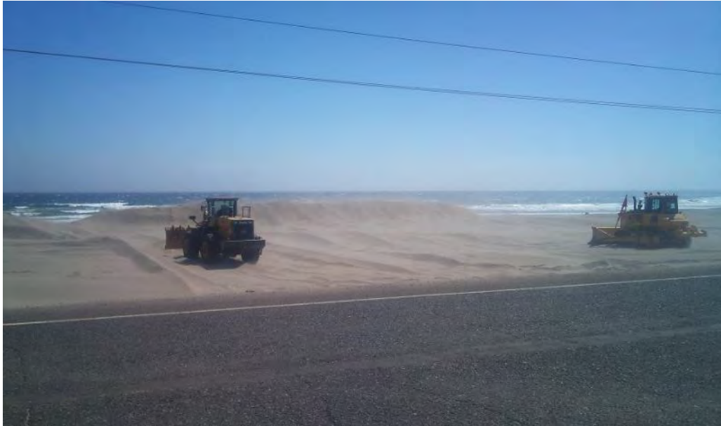
Foto 2.19 - Preparación del dique a 100 m. de la vía. Altura del dique 5 m.
