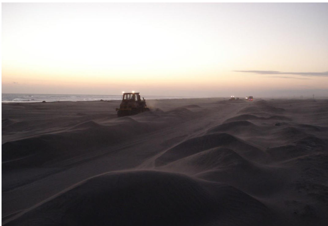
Foto 1.7 – Trabajos de equipos por formación de dunas en horas de la noche
