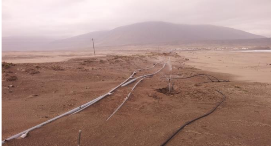
Foto 3.8 – Tendido de tubería PVC – SAP para línea de riego
