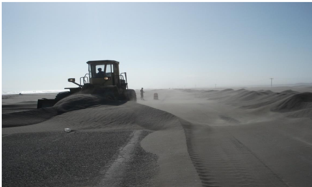
Foto 1.6 – Sector de carretera arenado, con trabajos de tractor neumático de PN, al atardecer
