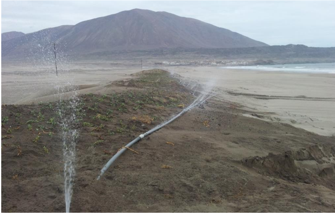
Foto 3.15 – Solución para el arenamiento en la carretera Panamericana Sur, kilómetro 580 - Tanaka.
