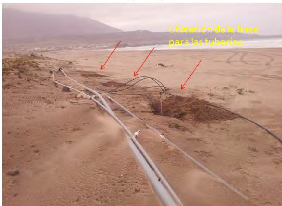
Foto 2.36 - Prueba de aspersores
