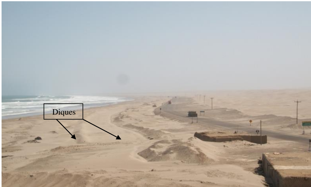
Foto 3.7 – Vista longitudinal de los diques construidos
