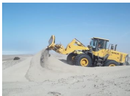
Foto 3.5 - Trabajos de desarenado con cargador
