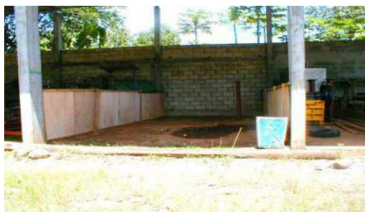
Fotografía 3. Centro de acopio acondicionado
