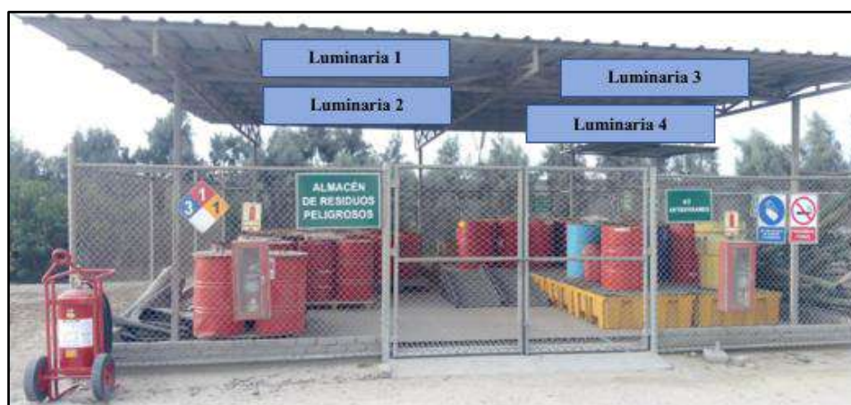
Figura 36. Colocación de luminaria en almacén central de residuos peligrosos. Fuente: Elaboración propia
