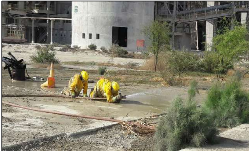
Figura 39. Brigada contra incendios y control de derrames. Fuente: Elaboración propia
