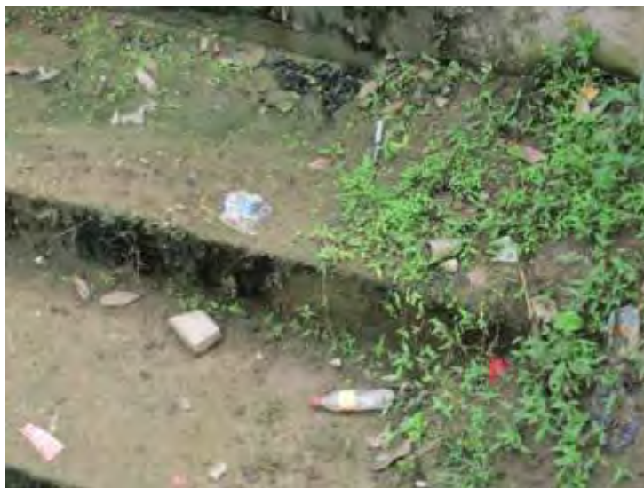
Figura 28 Quebrada ubicada debajo del puente de ingreso a la ciudad
