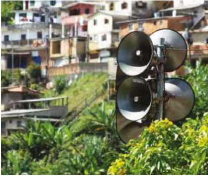
Sirenas de alerta de desastres en favelas de Rio de Janeiro, Brasil.
