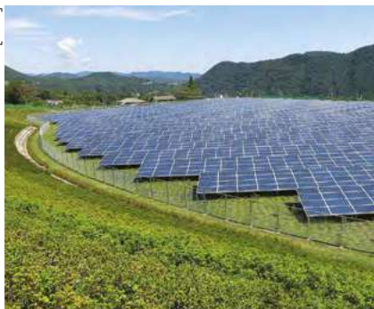
Granja de energía solar, ciudad de Aikawa, Japón
