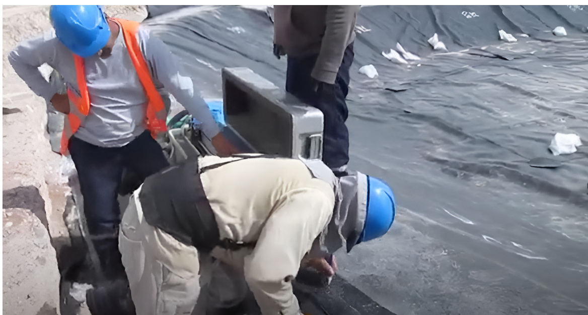
Imagen 11. Control de calidad soldadura geomembrana
