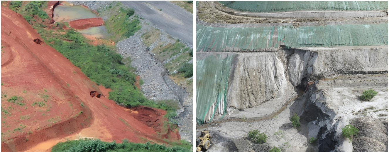
Imágenes 7 y 8. Imágenes de verificación de cierre con drones
