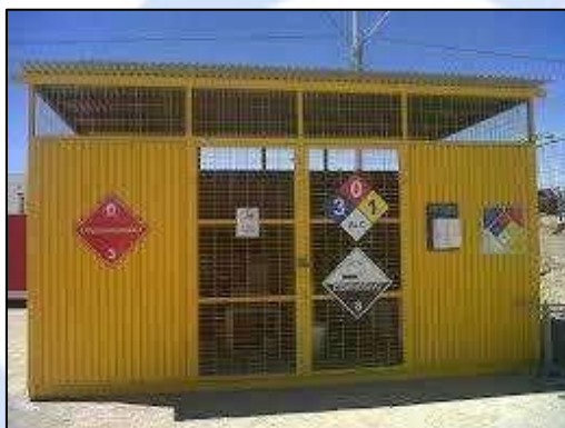
Figura 9: Modelo de almacén de Residuos Peligrosos
